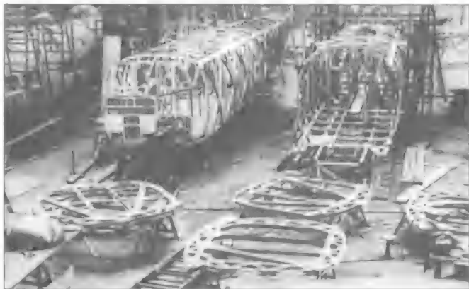
Сборка фюзеляжей Н.Р.42 на заводе в Рэдлетте.
